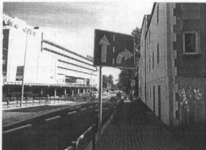
Rys 3. Nieprawidłowe usytuowanie lica znaku F-10 do osi jezdni na wlocie ulicy Tarnogórskiej
