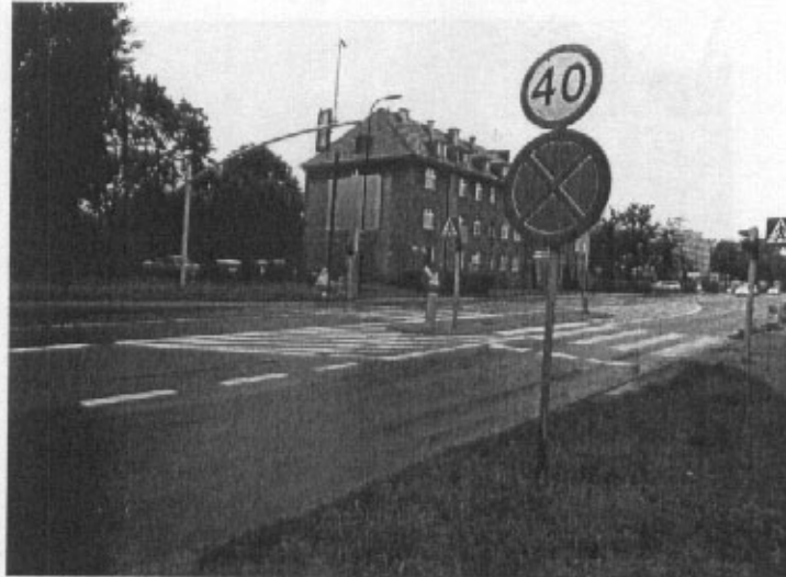
Rys 4. Zastosowanie oznakowania o nieprawidłowej grupie wielkości znaków przy prowadzeniu robót w pasie drogowym
