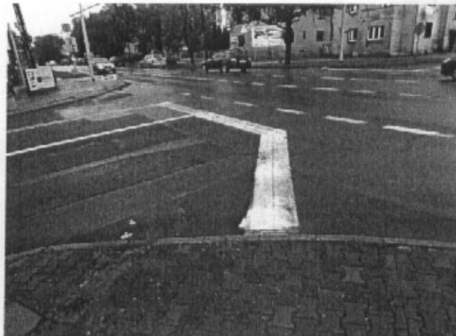
Rys 5. Wzajemna lokalizacja linii bezwzględnej zatrzymania oraz linii krawężniowej.
