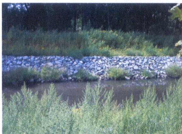
Wzmocnienie brzegów rzeki Kłodnicy
